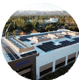
L'installation de panneaux photovoltaïques sur la toiture de l'établissement BOIRON situé en Californie a permis une diminution des 2/3 de la consommation d'électricité.
